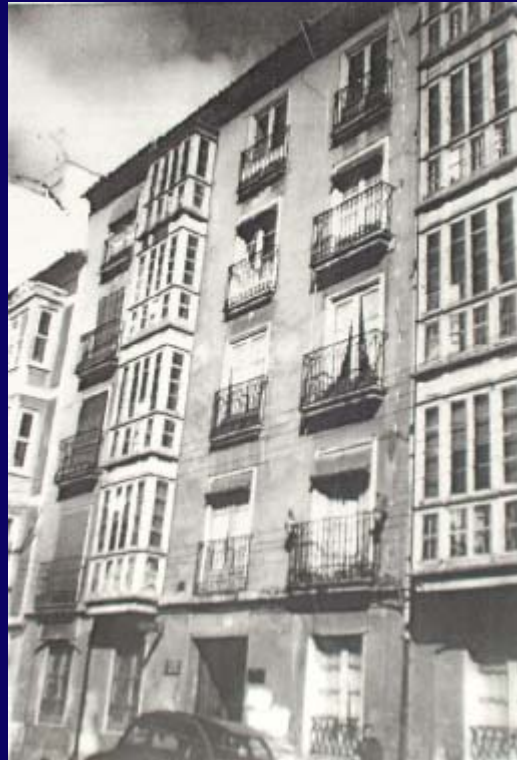
El edificio en 1960.
